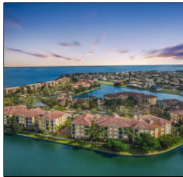
Vivante, Punta Gorda Storm Damage Assessment
